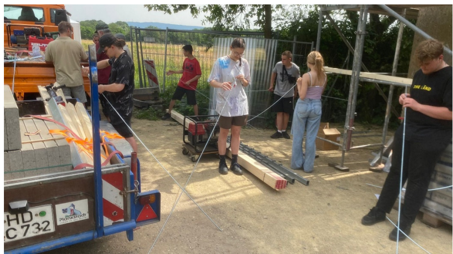
(Bau des Jugendplatzes mit Jugendlichen am Trafoturm)
