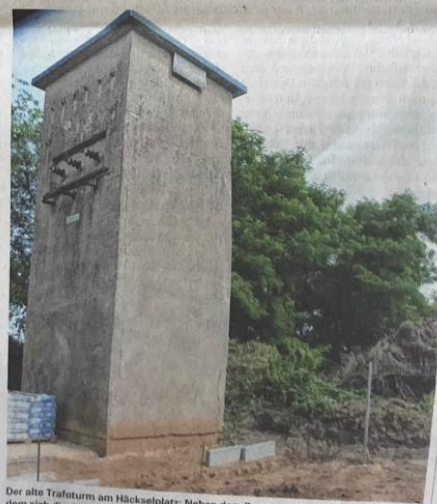
Der alte Trafoturm am Häckselplatz: Neben dem Bau entsteht ein neuer Bereich, an dem sich die Jugend ungestört treffen kann. BILD: MONTALBANO
